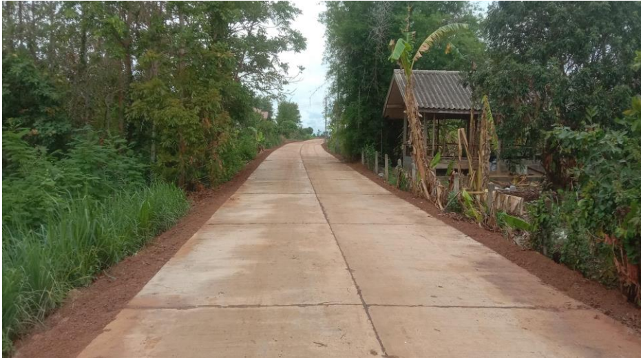
14.โครงการก่อสร้างถนนคอนกรีตเสริมเหล็ก ซอยโคกรัก2 หมู่ที่ 7 บ้านโคกรัก
