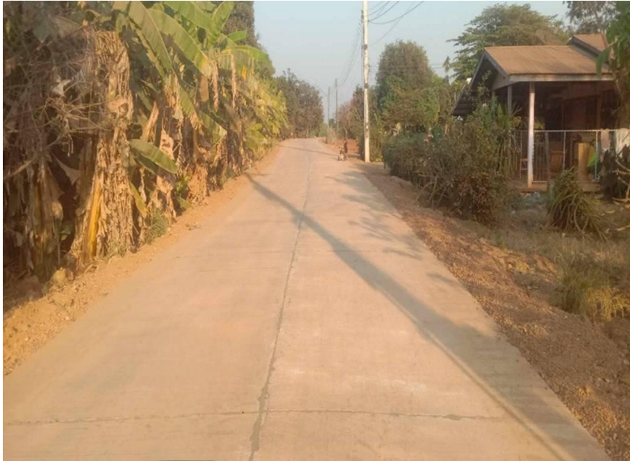
11.โครงการก่อสร้างถนนคอนกรีตเสริมเหล็ก ถนนจันทนะ หมู่ที่ 1 บ้านโนนสุวรรณ
