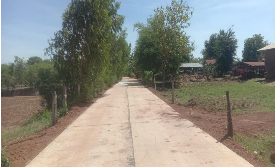
20.โครงการก่อสร้างถนนคอนกรีตเสริมเหล็ก ถนนโคกสามัคคี (ช่วงที่เหลื่อ) หมู่ที่ 6 บ้านโคกสามัคคี
